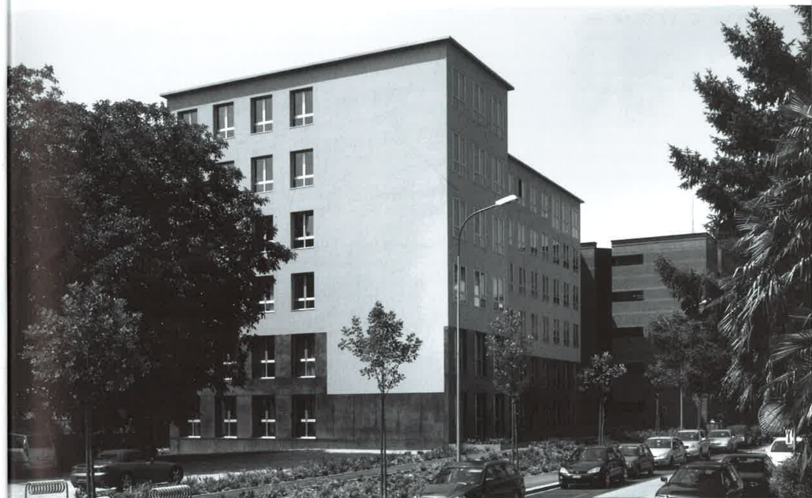
Prima fase di realizzazione
